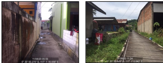
Gambar 2. Salah satu kondisi jalan lingkungan RT. 02 & 03
