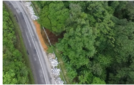
Gambar 4. Lokasi Longsor (sumber: dokumen proyek, 2017)
